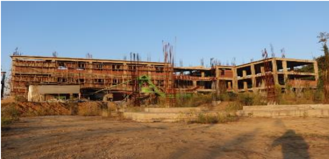
चित्र 5.26: निर्माणाधीन विभागीय भवन
