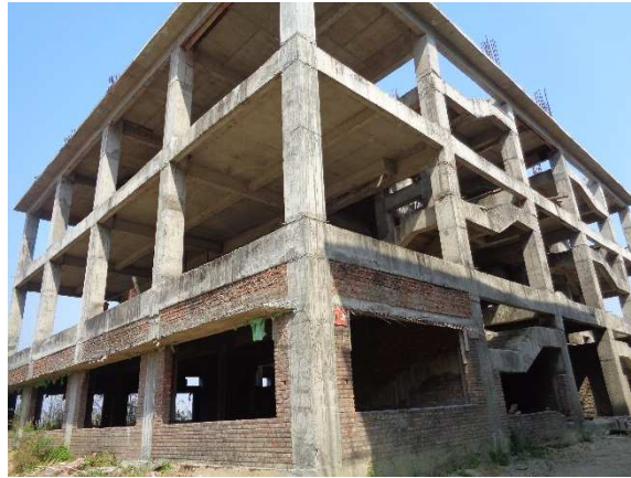
चित्र 7.7: निर्माणाधीन पुस्तकालय सह डाटा सेंटर
